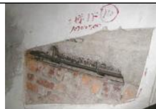
Anti-rust Treatment 防銹處理
