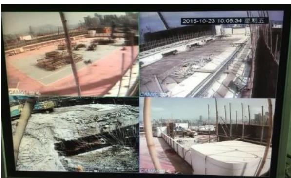
CCTV Monitoring of Demolition Process 閉路電視全程監錄拆卸過程
